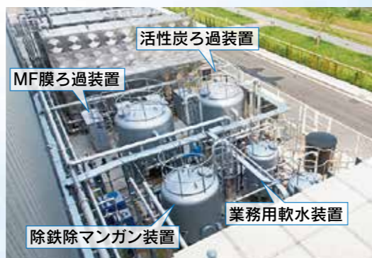
処理能力: 100m 3 /h 用途: 製造用水
