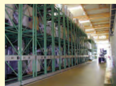
ボイラ自動立体倉庫
